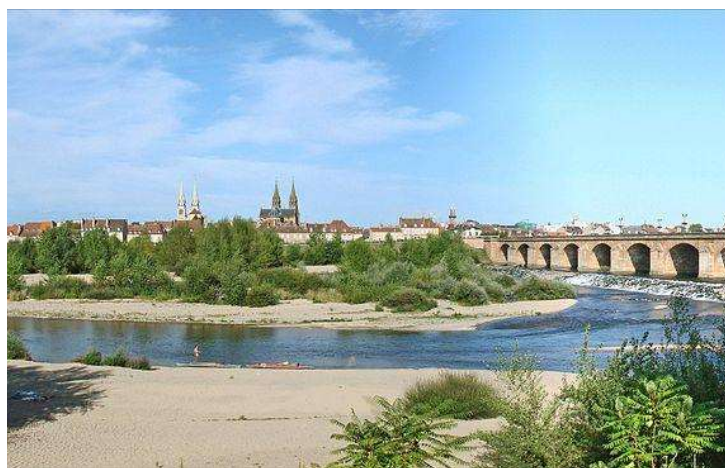
Pont Régemortes à Moulins
