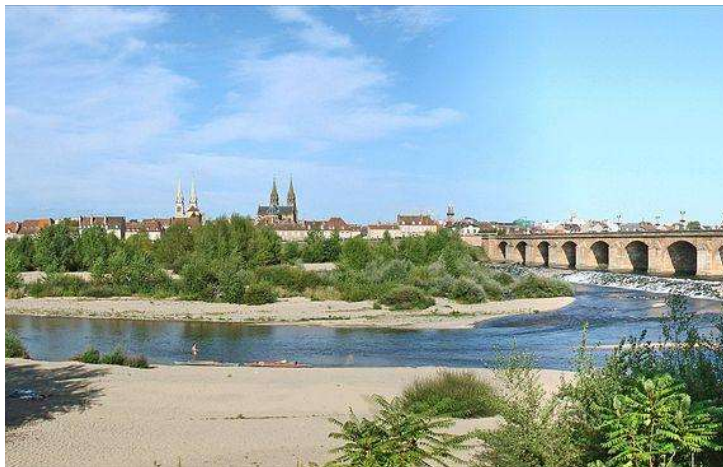
Pont Régemortes à Moulins
